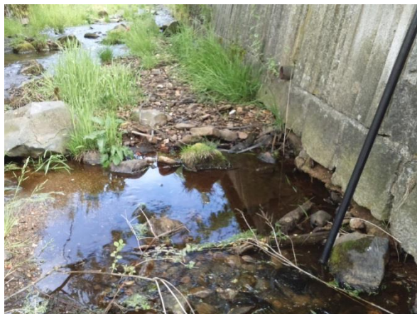
Foto 10: Detail na podemletou část paty nábrežní zdi, patrný sediment
