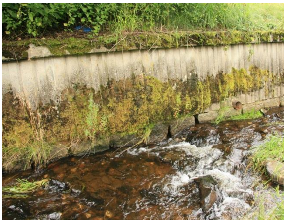
Foto 14: Detailní pohled na betonovou zeď v ř. km 4,457 (práh ve dně). Prefabrikát porostlý mechem. Zeď je podemletá a spárování mezi kopáky místy chybí
