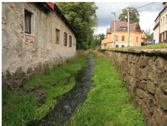
Foto 2: Pohled z mostu M1 proti vodě - pevnění nábrežní zdi z režného zdiva do cementové malty s železobetonovou římsou. Na pravém břehu budova, ve dně dlažba tvarovaná do střelky
