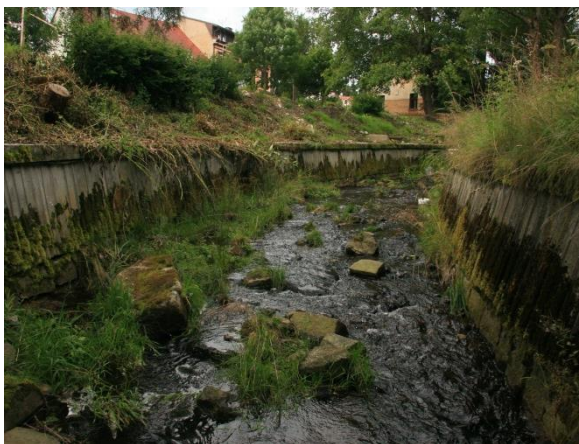
Foto 11: Ř. km 4,394 pohled proti vodě - úsek toku s opevněním nábrežních zdí bet. prefabrikovanými dílci. Místy jsou ve dně volné kameny, které fungují jako rozražeče
