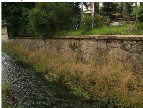
Foto 4: Pohled po vodě ze stejného místa - režné zdivo, které je potřeba přespárovat. Ve dně travní drn, který zmenšuje kapacitu profilu
