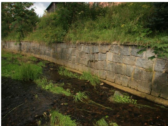
Foto 7: Pohled proti vodě ze stejného místa na levý břeh. Konstrukce zdi z řádkového zdiva, římsa porostlá vegetací, pata zdi podemletá, místy sediment
