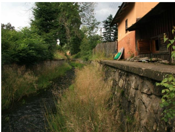
Foto 3: Ř. km 4,340 pohled proti vodě - ve dně patrný sediment a travní drn. Na levém břehu budova s plotem a na pravém břehu hustá vegetace
