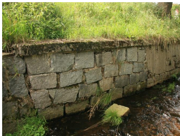
Foto 8: Ř. km 4,383 pohled na pravý břeh - konstrukce zdi délky 3 m je v nevyhovujícím stavu. Spáry jsou porušené (především v spodní části konstrukce).
