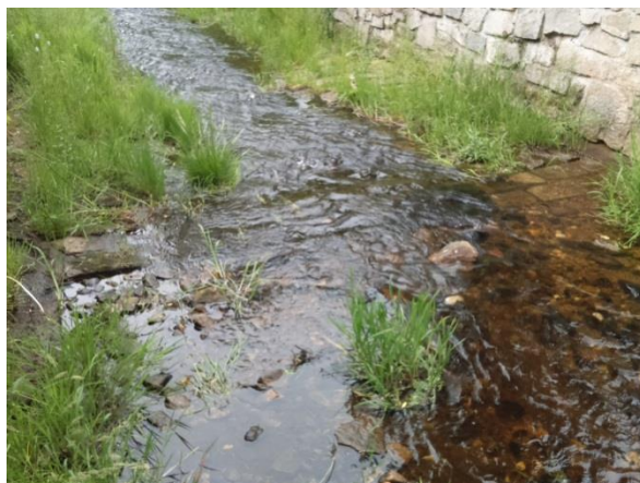
Foto 6: Ř. km 4,361 - změna opevnění dna ze záhozu na kamennou dlažbu. Změna je stabilizována kamenným pasem. Konstrukce opěrné zdi se ve stejném místě mění z režného zdiva na řádkové.
