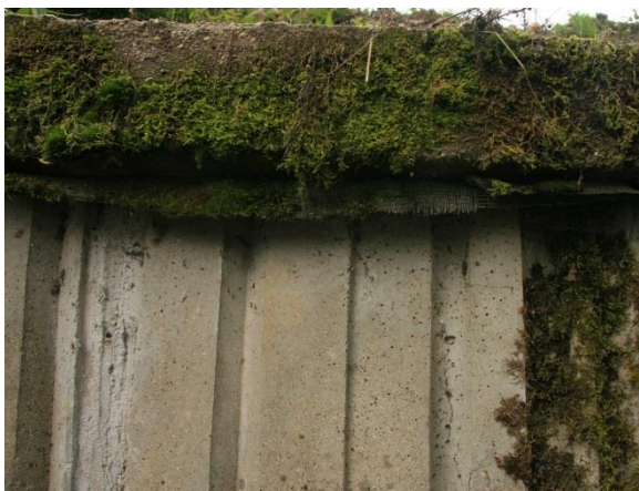
Foto 13: Detailní pohled na římsu, která je porostlá mechem, pod římsou vyčnívá geotextilie, patné praskliny na IZT prefabrikátu
