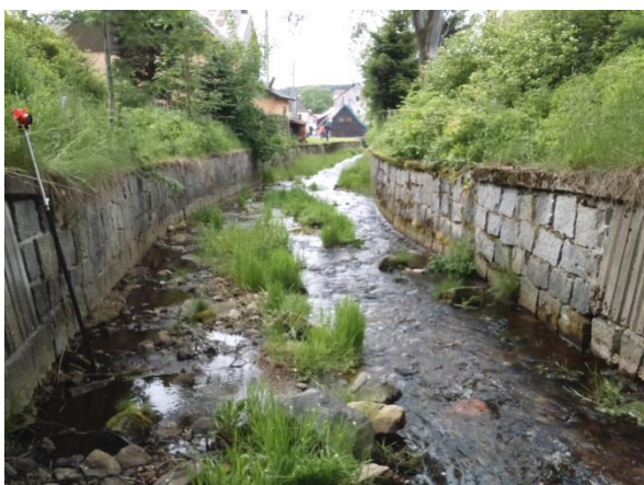
Foto 9: Ř. km 4,386 pohled po vodě - měna opevnění nábrežních zdí z prefabrikované betonové konstrukce uložené na kopáky na zděnou opěrnou zeď (řádkové zdivo).
