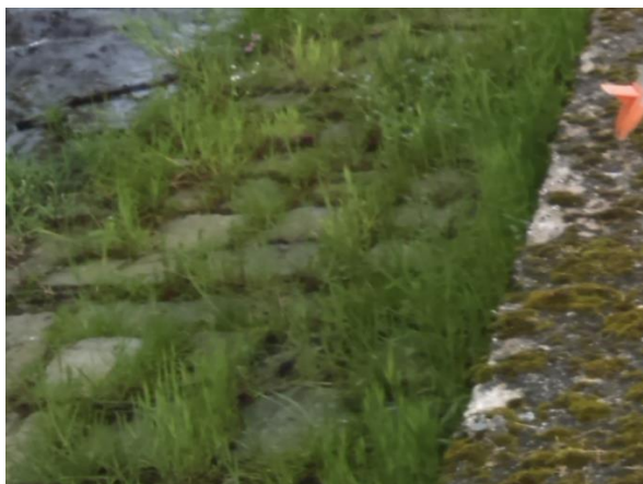
Foto 5: Detailní pohled na opevnění dna kamennou dlažbou, patrný travní drn
