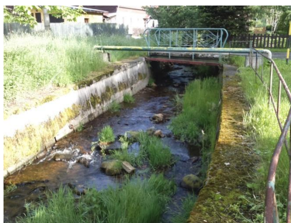
Foto 18: Ř. km 4,486 most M2 pohled proti vodě – konec řešeného úseku. V pohledu produktovod na bet. patkách. Ve dně je místy travní drn.
